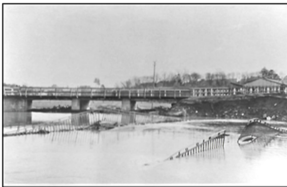
La grille du pont des Maures au fond de l'eau et en arrière-plan la passerelle provisoire
