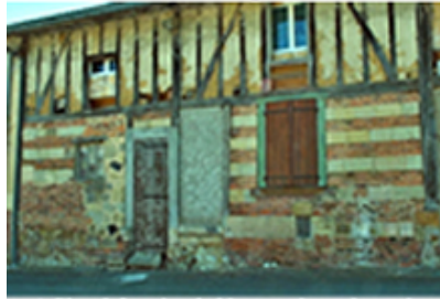
A Chaudefontaine, habitat rural avec le rez de chaussée en gaize et briques et l'étage à pans de bois.
