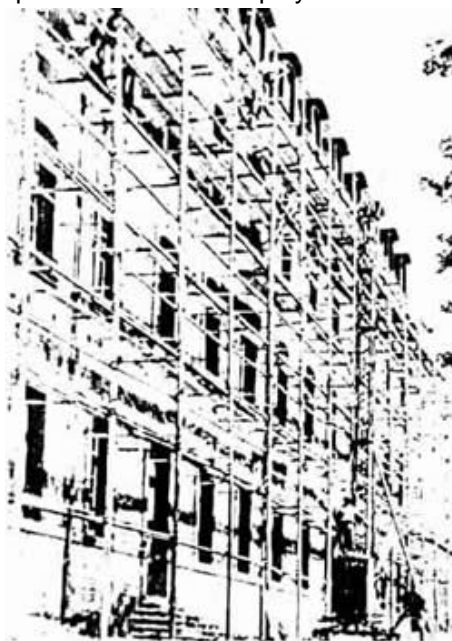
Un échafaudage de l'entreprise BUACHE, tout en tronc de sapins (ravalement de la caserne)
